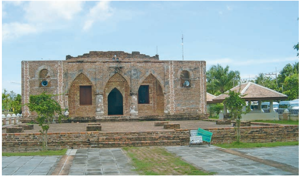
Mosquée inachevée/Sud de Thaïlande
