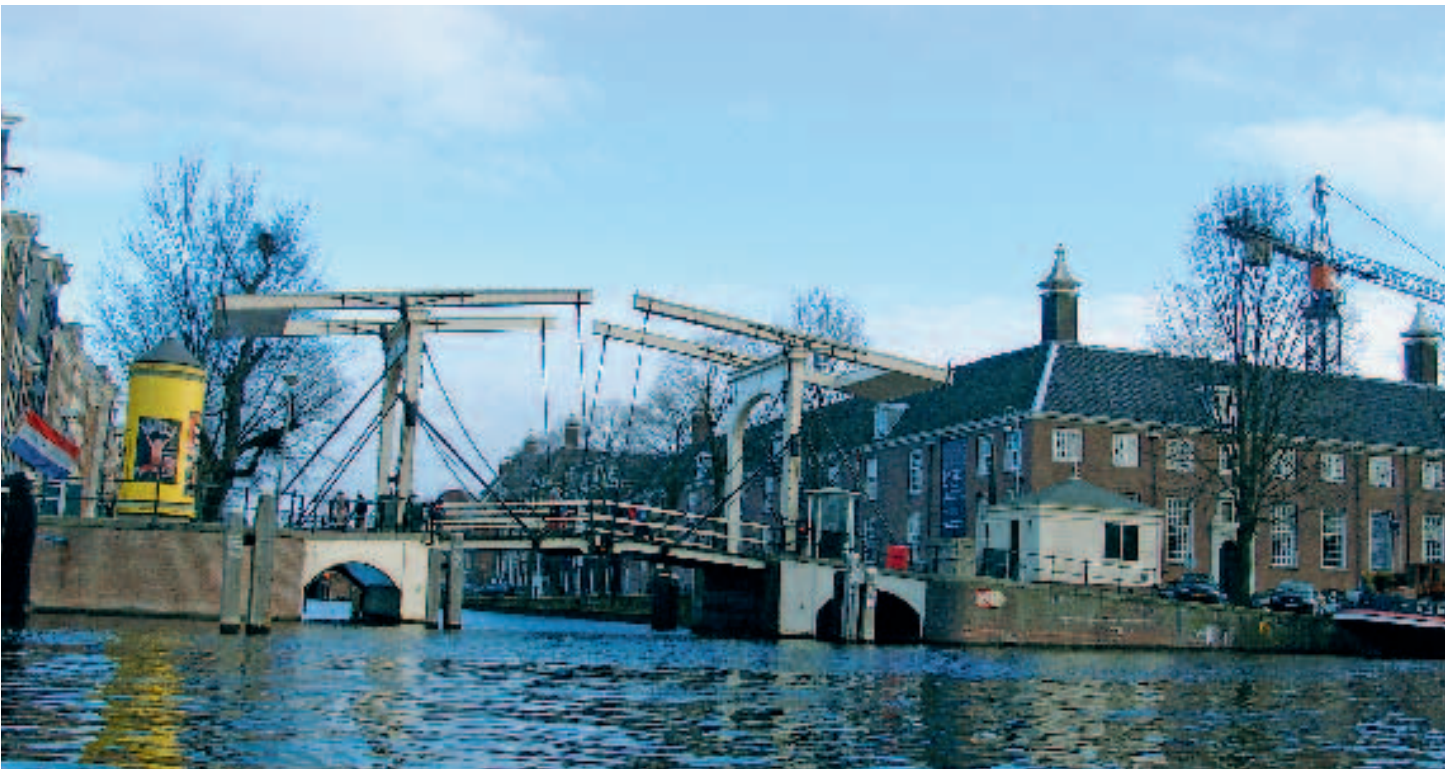
Pont au port
