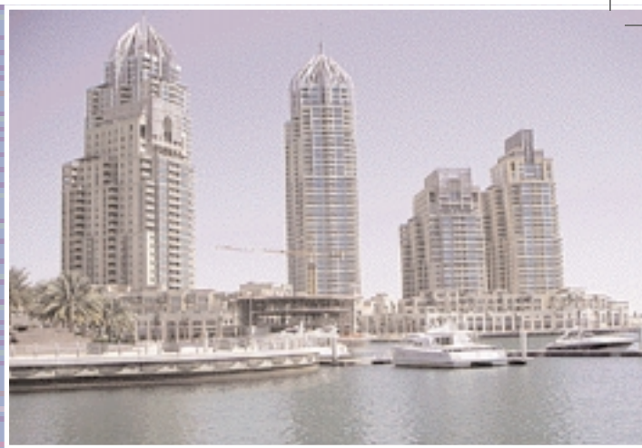
إلى منطقة التراث. Dubai, la post-moderne.
