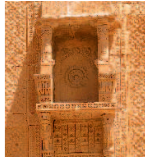
Détails du mur
