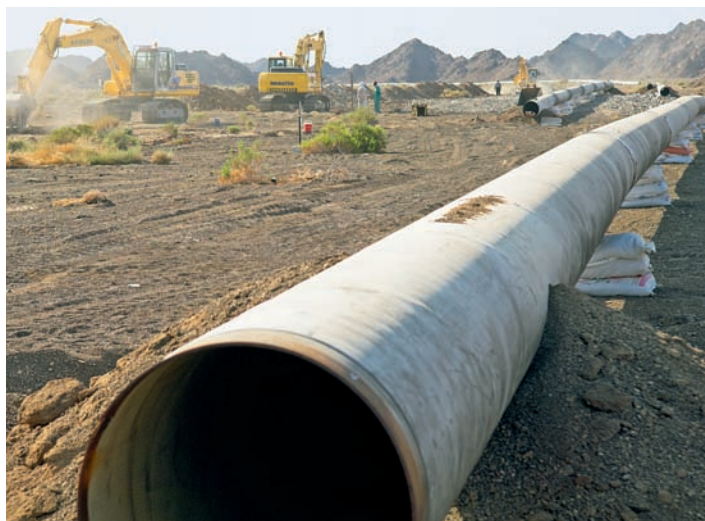
Die neue Wasserleitung
