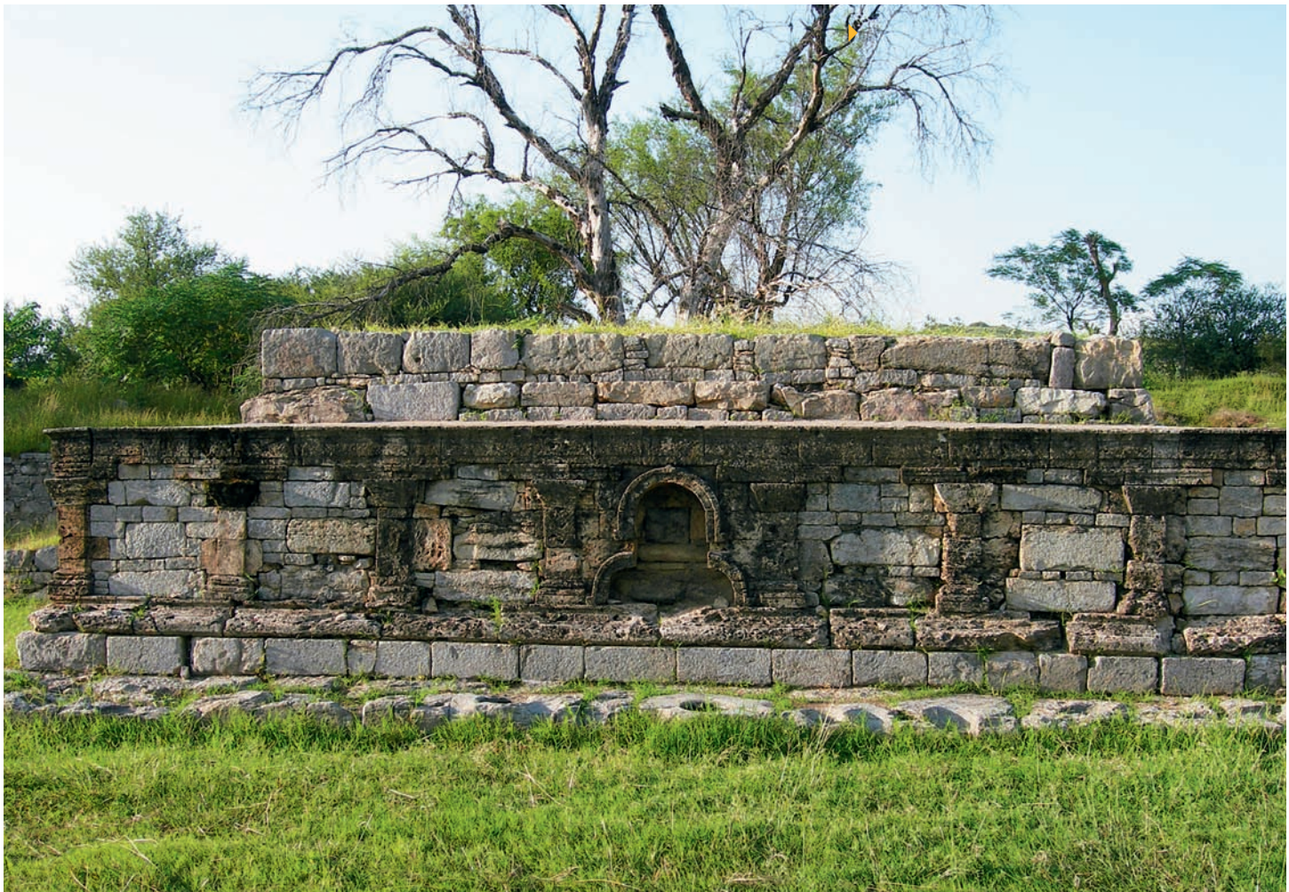
Detailaufnahme der Mauer
