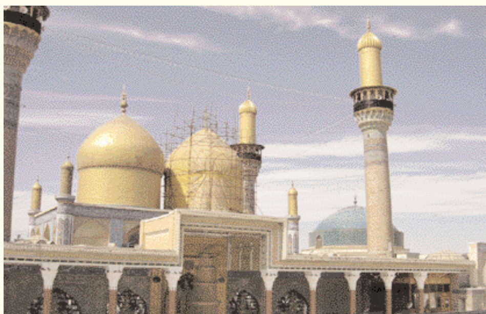
Vue extérieure des mausolées
