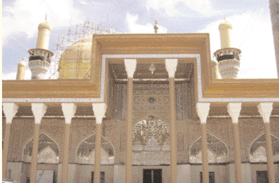
Restauration de la porte de l'ouest
