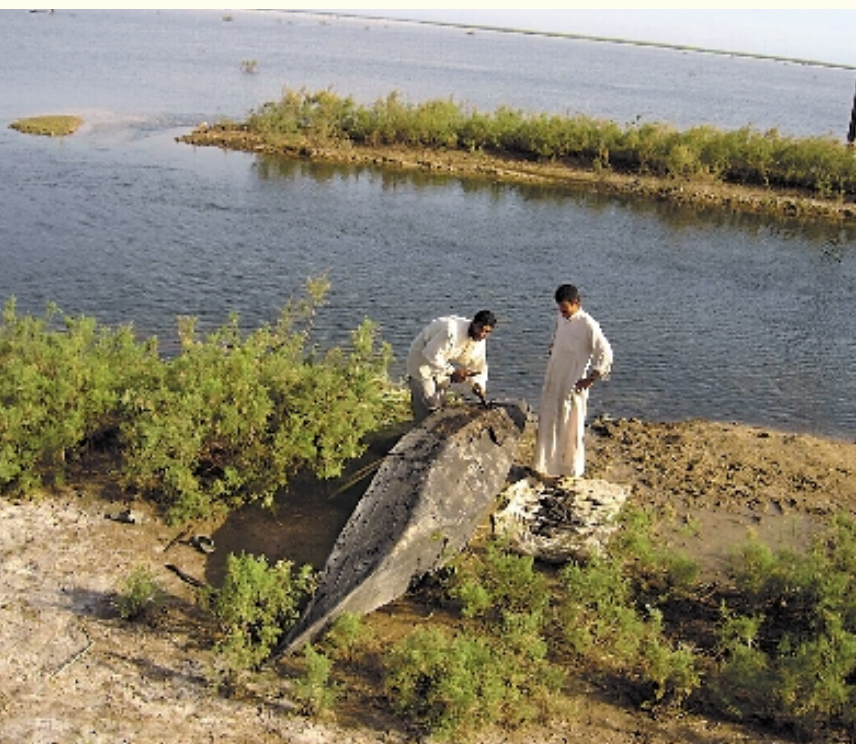
Réparation de barques.
