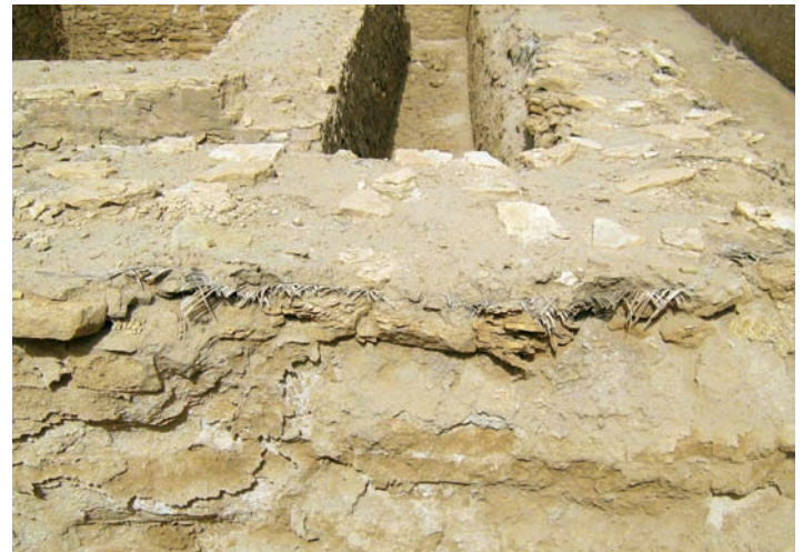
مادة القصب والحصير المستخدمة في بناء سياج القصر الملكي لـلكامش Reed and mats used in building the walls of Gilgamesh's Palace
