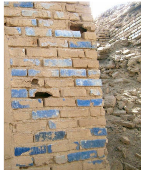
أحد جدران المعبد ويلاحظ لون الطابوق المزجج A wall in the temple built with glazed bricks
