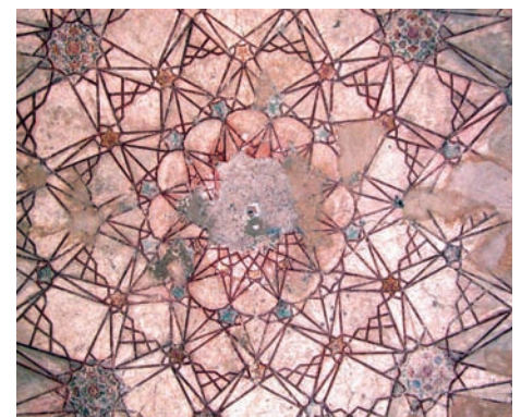
Pattern inside the arch of entrance زخرفة في قوس المدخل
