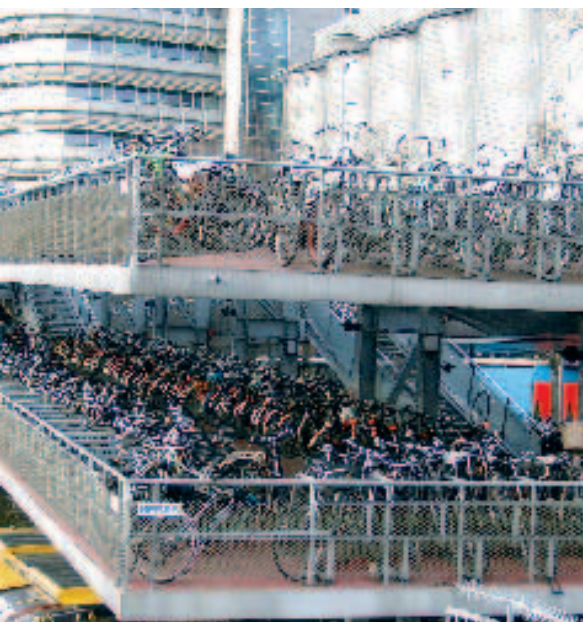
Bicycle parking garage موقف الدراجات الهوائية
