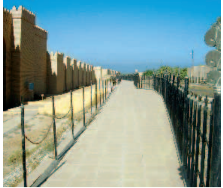
Vista parcial de la Calle de la Procesión
