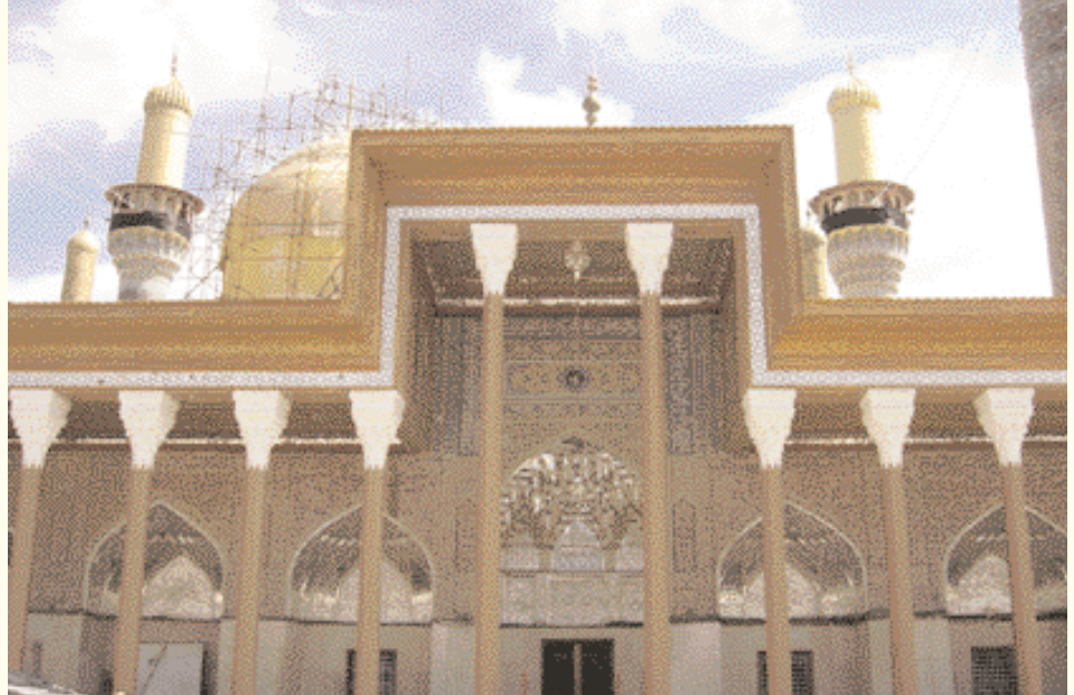
Reparaturarbeiten am Westtor
