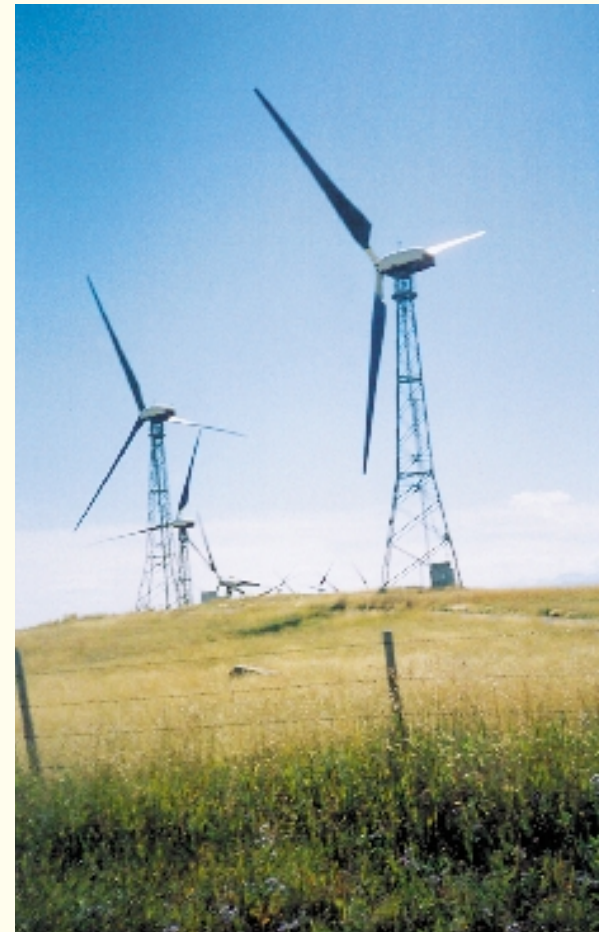
دورات الهواء في محطة كهرباء كاولي ريج، أول محطة هوائية تجارية في كندا.
